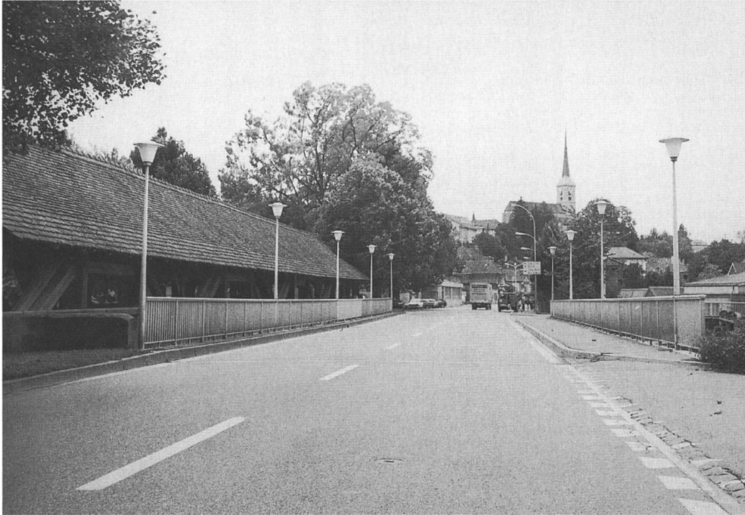
Alte und neue Innere Wynigenbrücke um 1989 (Foto: Daniel Mumenthaler)
