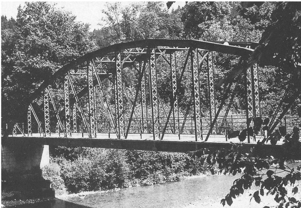
Die 1902 als Eisenfachwerk-Konstruktion erbaute Lochbachbrücke (Foto: Peter Wegmüller)
