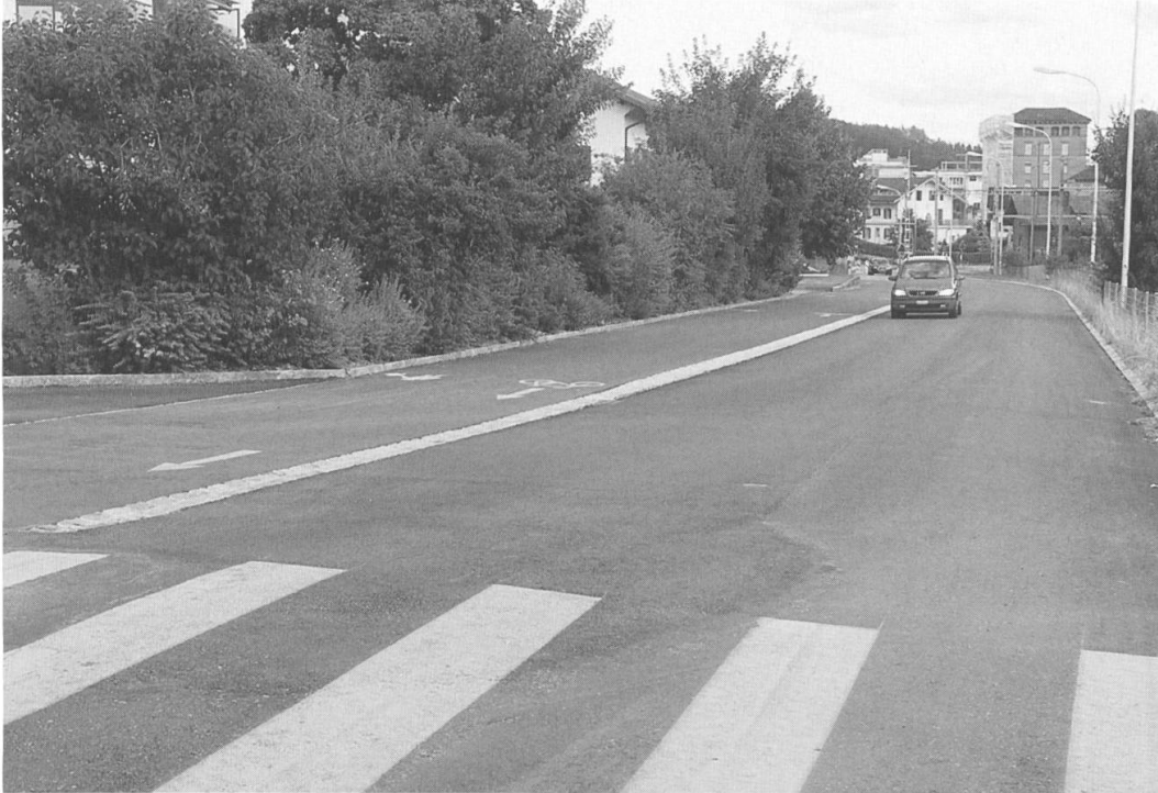
Nach und nach erhält die Steinhofstrasse ihr neues Gesicht – inklusive Radstreifen. Das Trassee ist für diesen viel befahrenen Strassenzug recht schmal geraten!
