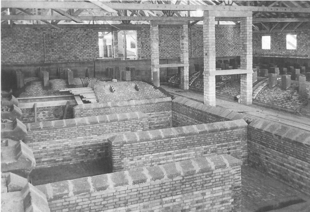
Bau des Zickzack-Ofens 1949
