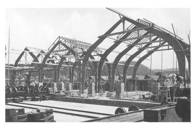
Beim Bau der Werkstätte waren die um 1914 durch die Firma Gribi hergestellten Brettschichtholzträger (noch unverleimt, mit Klammern gehalten) deutlich sichtbar. Die Fassaden wurden später aufgemauert und haben keine tragenden Funktionen (Foto: Nachlass L. Bechstein im Burgerarchiv Burgdorf)
