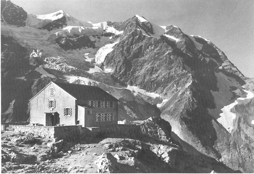
Die Glectsteinhütte vor dem Umbau, mit Ankenbälli und Mettenberg
