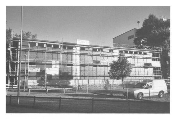
Der neue Pavillon bei der Schulanlage Gsteighof, dessen vorfabrizierte Elemente innert eines Tages zusammengefügt wurden
