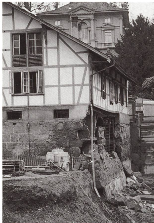
Überraschung auf der Baustelle des Franz-Gertsch-Museums: Die Grundmauer des unter Denkmalschutz stehenden ehemaligen Milka-Käselagers stürzt teilweise ein
