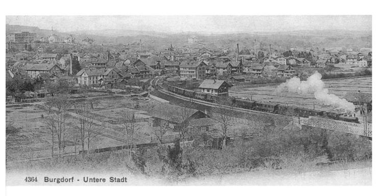
Ein Schnellzug fährt Richtung Olten über die von 1856 stammende, eiserne Gitterbrücke. Erkennbar ist davor die für die Doppelspur 1895 in ähnlicher Art gebaute zweite Brücke (Postkarte um 1910)
