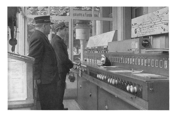
Die elektrische Hebelstellwerkanlage von 1943 im Bahnhof SBB verbesserte die Betriebssicherheit. Sie wurde am alten Standort in einer Kabine errichtet (Foto-Service SBB, Aufnahme 8. 10. 1954)
