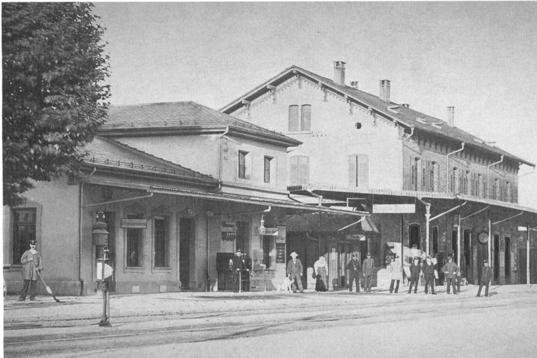
Ursprüngliches Aufnahmegebäude, von der Bahnseite her gesehen: Auf dem Hausperron, vor dem kleinen Dienstgebäude, ist das mechanische Vorstandsstellwerk auszumachen (Foto um 1900)
