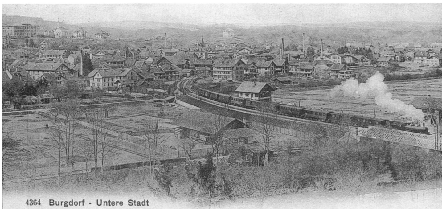
Ein Schnellzug fährt Richtung Olten über die von 1856 stammende, eiserne Gitterbrücke. Erkennbar ist davor die für die Doppelspur 1895 in ähnlicher Art gebaute zweite Brücke (Postkarte um 1910)
