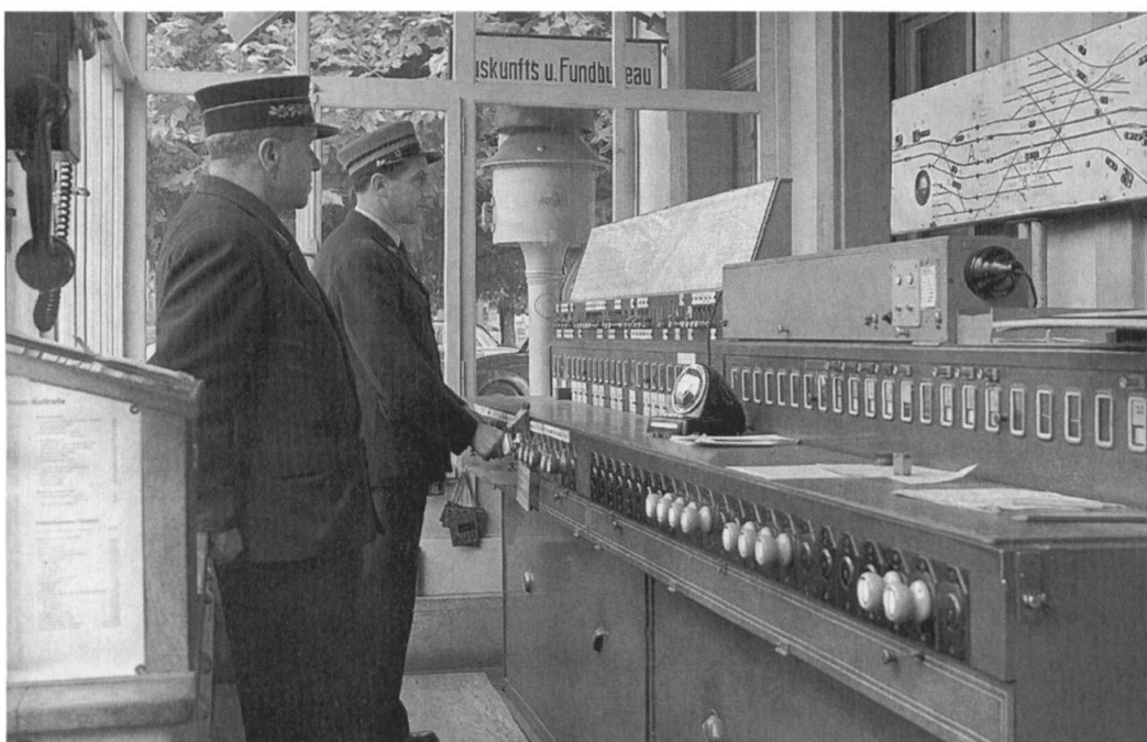
Die elektrische Hebelstellwerkanlage von 1943 im Bahnhof SBB verbesserte die Betriebssicherheit. Sie wurde am alten Standort in einer Kabine errichtet (Foto-Service SBB, Aufnahme 8. 10. 1954)
