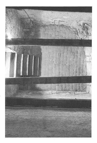
Blick vom heutigen Eingangsgeschoss im Bergfried ins sieben Meter tiefe Verlies. Während der Renovationsarbeiten wurden die Holzbretter des Zwischenbodens entfernt, so dass nur noch die Balkenlage sichtbar ist. Mit der Renovation des Verlieses, welches bis vor zwei Jahren noch als Keller genutzt wurde, wird nun der ganze Bergfried dem Besucher zugänglich gemacht.
