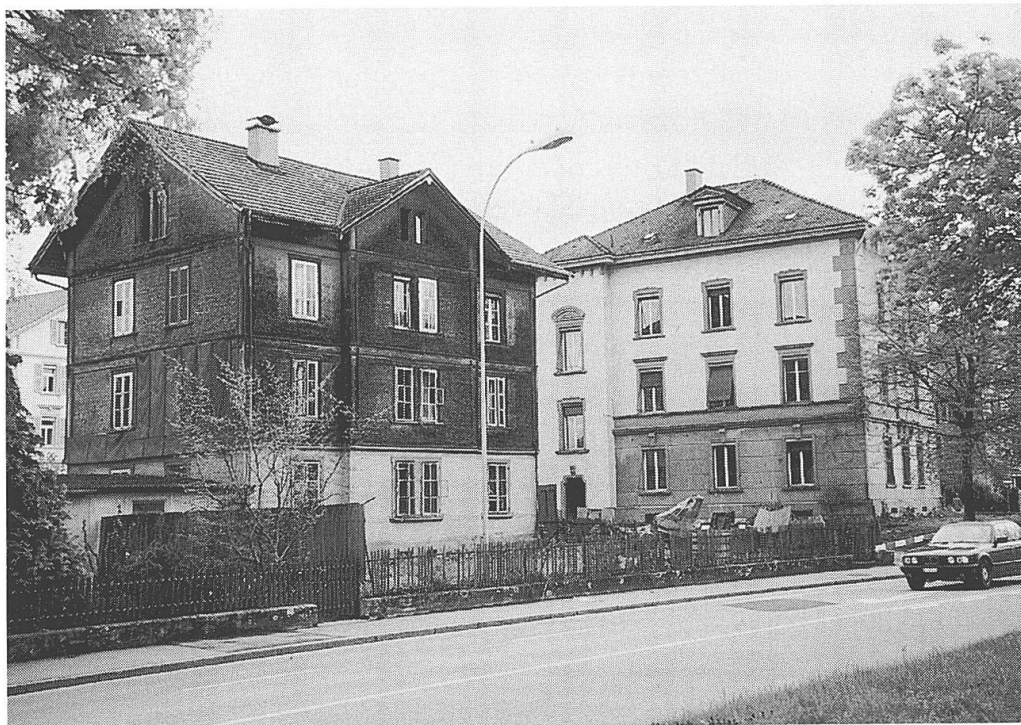
Gegenüber dem Neumarkt soll das neue Hotel Berchtold entstehen. Deswegen ist das Haus an der Lyssachstrasse neben der denkmalgeschützten Zumstein-Liegenschaft abgebrochen worden
