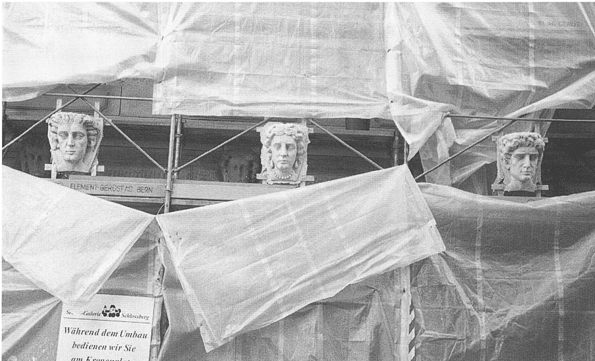
Wo sind sie zu finden, diese drei Sandstein-Köpfe? – Das markante Gebäude an der Ecke Schmiedengasse/Neuengasse, die ehemalige «Mädere», wird saniert
