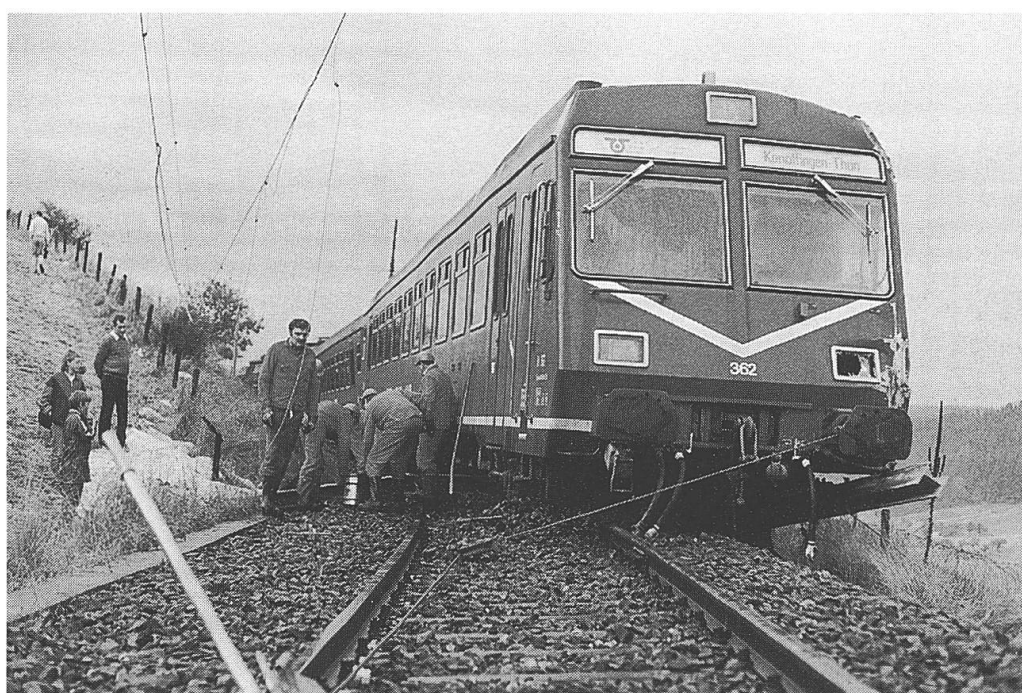
Die Fotografie zeigt den Schaden am Fahrzeug und an der Fahrleitung, und mit wie viel Glück dank der stützenden Wirkung des Fahrleitungsmastes schlimmere Folgen verhütet wurden.
