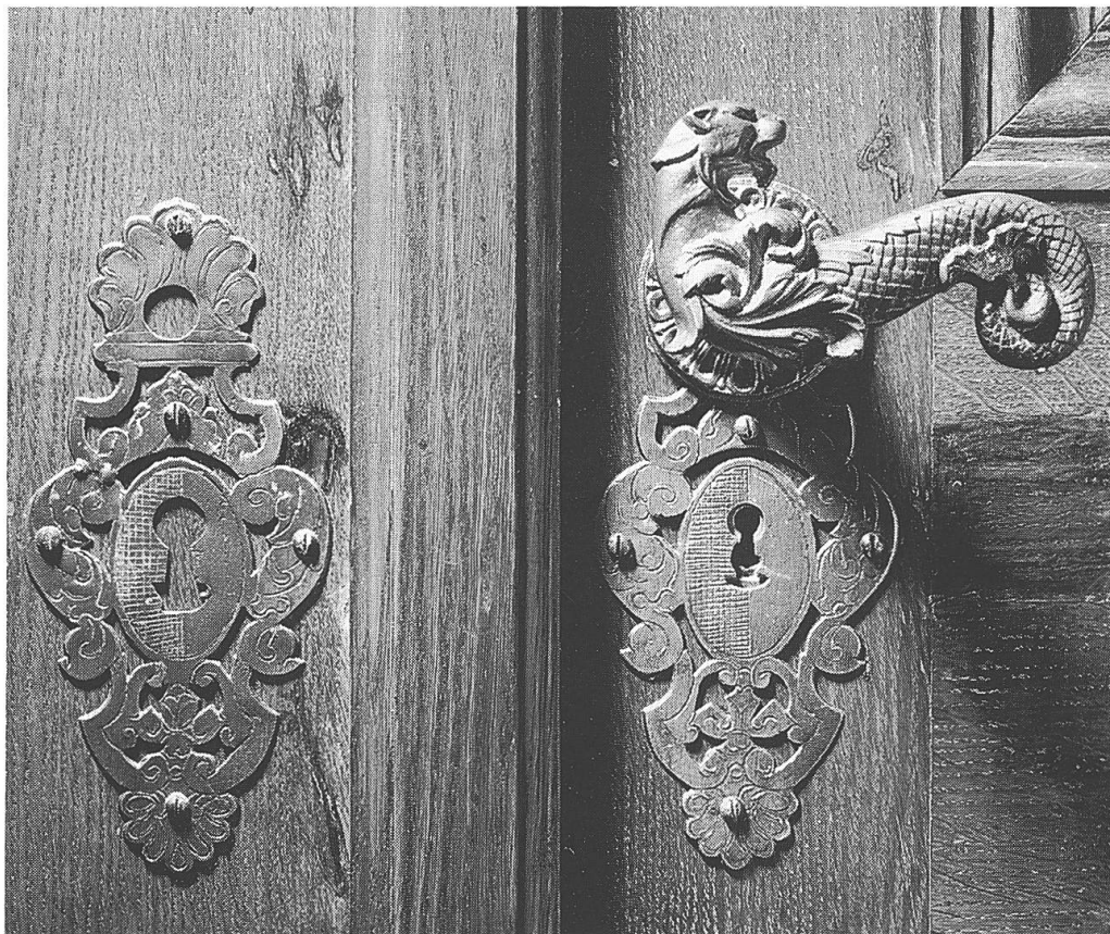
Abb. 11 Stadthaus, Haustüre von 1742/45, Beschläge wohl von Schlosser Johann Jakob Schnell. Der Funktion als Rathaus entsprechend tragen selbst die Schlüsselschildchen das Stadtwappen. Türdrücker Gusseisen, wohl um 1870
