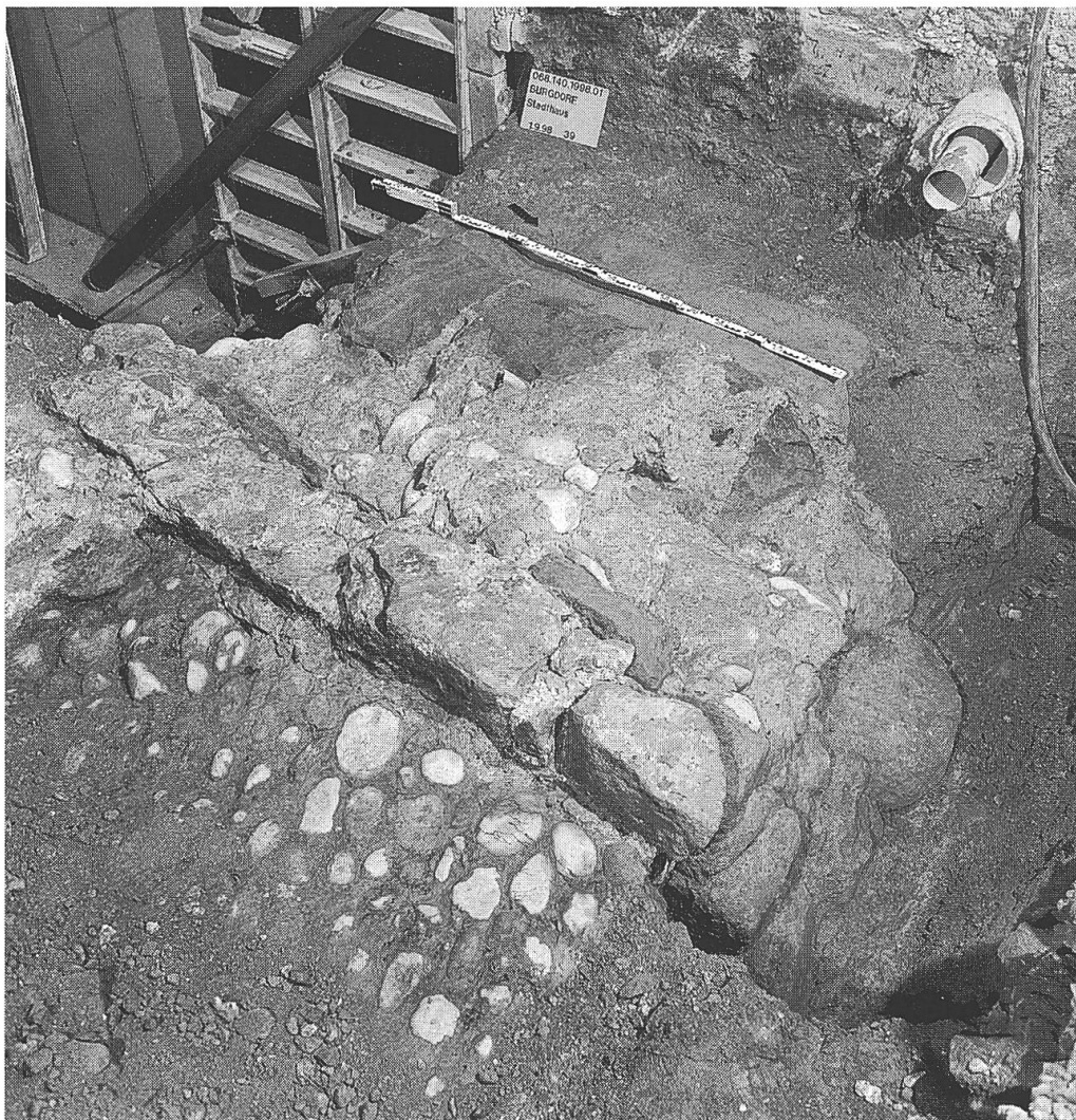
Abb. 4 Die Westmauer des mittelalterlichen Rathauses mit der anstossenden Kieselplasterung des Kellerbodens (Blick nach Südwesten)
