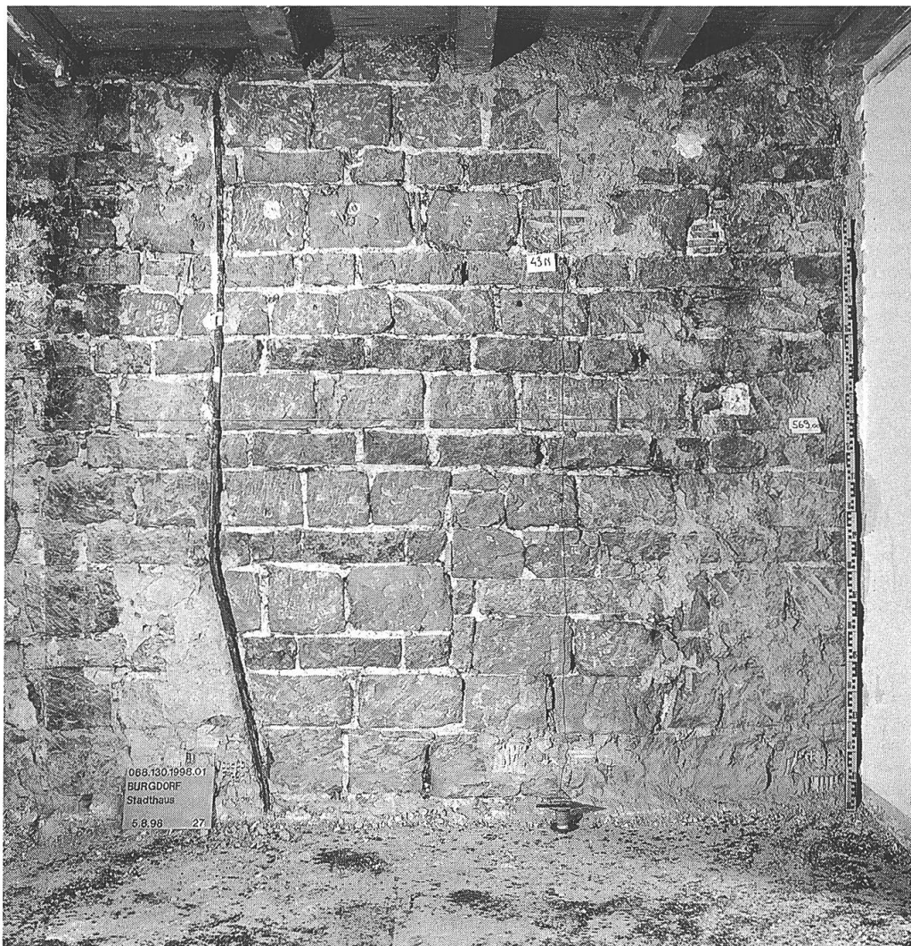
Abb. 5 Ein Ausschnitt der spätmittelalterlichen Brandmauer zu Kirchbühl 4. Sie besteht aus sorgfältig gefügten Lagen, bei denen Sandsteinquader und Backsteine abwechseln (Blick nach Westen)
