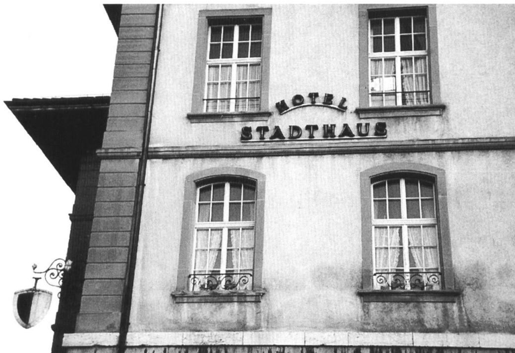
Das Hotel Stadthaus wird einer umfassenden Sanierung unterzogen
