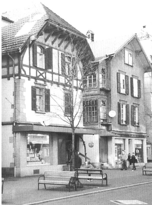
Die Abbruchliegenschaften an der Bahnhofstrasse 15 und 17
