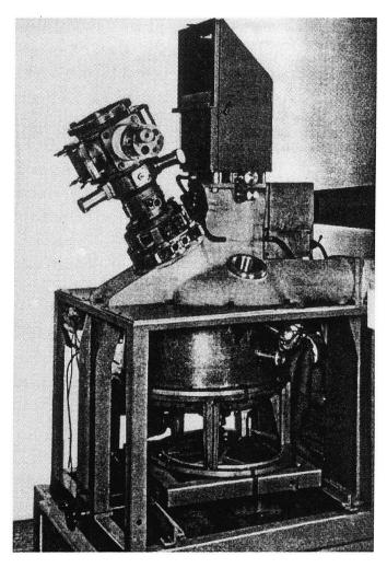
Prototyp eines Eidophor-Fernsehgrossprojektors
