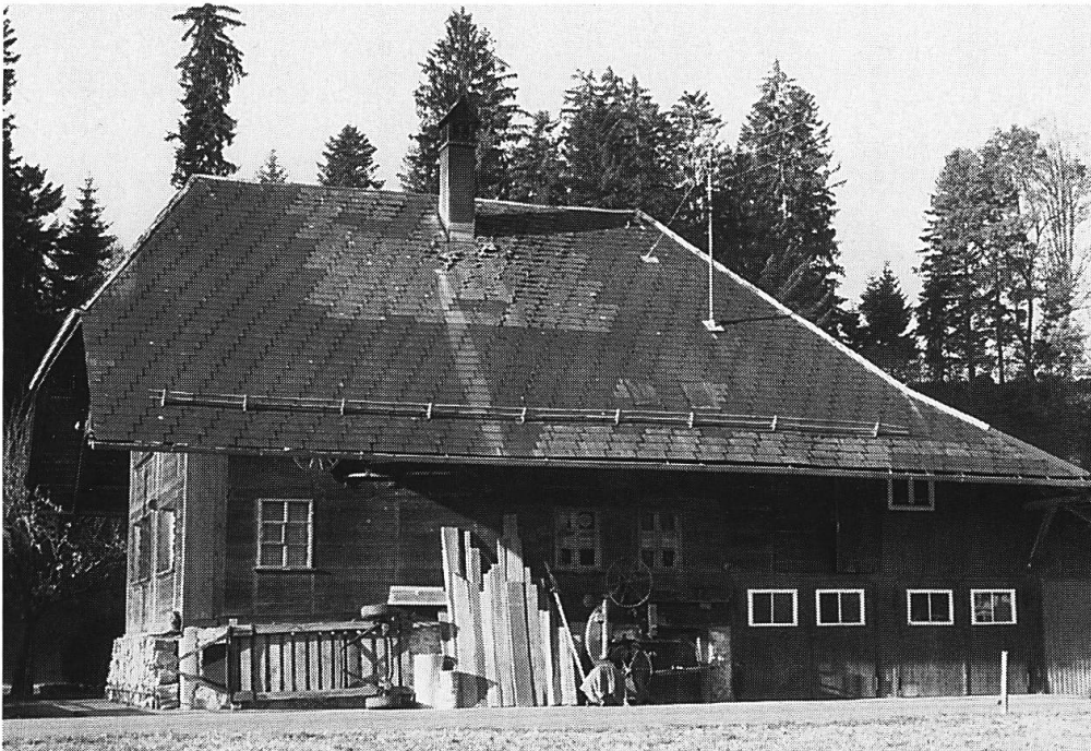
Abb. 10 Das Haus des Zimmermeisters Urs Tällenbach heute: Der 1959 stark umgebaute Wohnteil (links) mit dem mehrfach veränderten Ökonomieteil (rechts)
