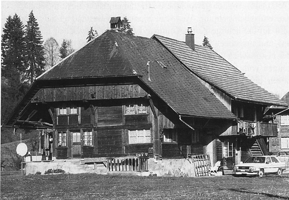
Abb. 9 Das Haus des Zimmermeisters Hans Gottier heute: Der alte Wohnteil (Vordergrund) mit massiv veränderter Front, anstelle des Ökonomieteils der grössere Wohnbau von 1924 (Hintergrund)
