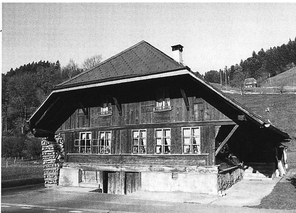
Abb. 8 Schachenhaus mit ehemaligem Webkeller in der Hüselmatt am Weg von Langnau in den Mungnauschachen. Eingangstür zum ehemaligen Webkeller links, Fenster mit Läden verschlossen
