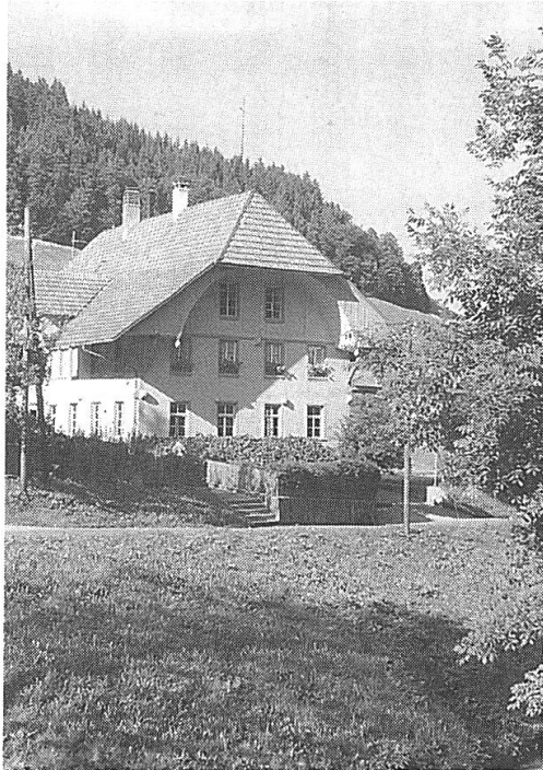
Abb. 5 Biembach/Hasle. Schulhaus, erbaut 1899, 1966 zugunsten eines Neubaus abgerissen.
