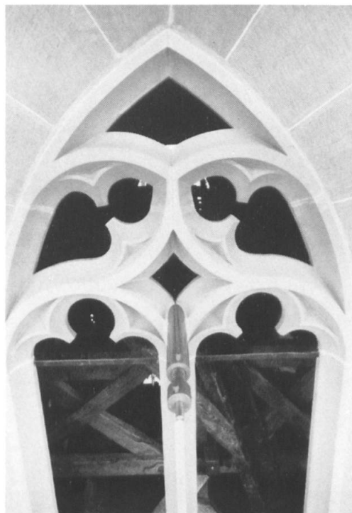
Schallöffnungen mit Uhrzeigerachse am Kirchturm, Masswerk 1987/88.
