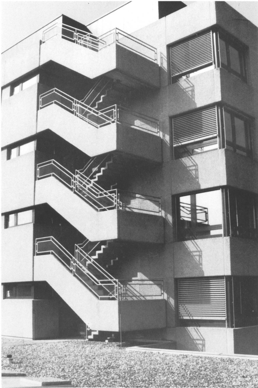
Neubau Spital Burgdorf 1977/80, Fassadenelemente Nottreppe (WB 8–16 Napoleon, bzw. Sichtbeton).
