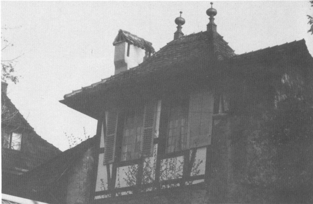
Am Alten Markt 10 steht das letzte erhaltene historische Gartenhaus der Stadt. Das schmucke Gebäude mit einem Rieggeschoss unter dem Walmdach wurde 1754 direkt auf die Stadtmauer gebaut, davor liegt ein grosser Garten mit einem zweiten Gartenhaus.
