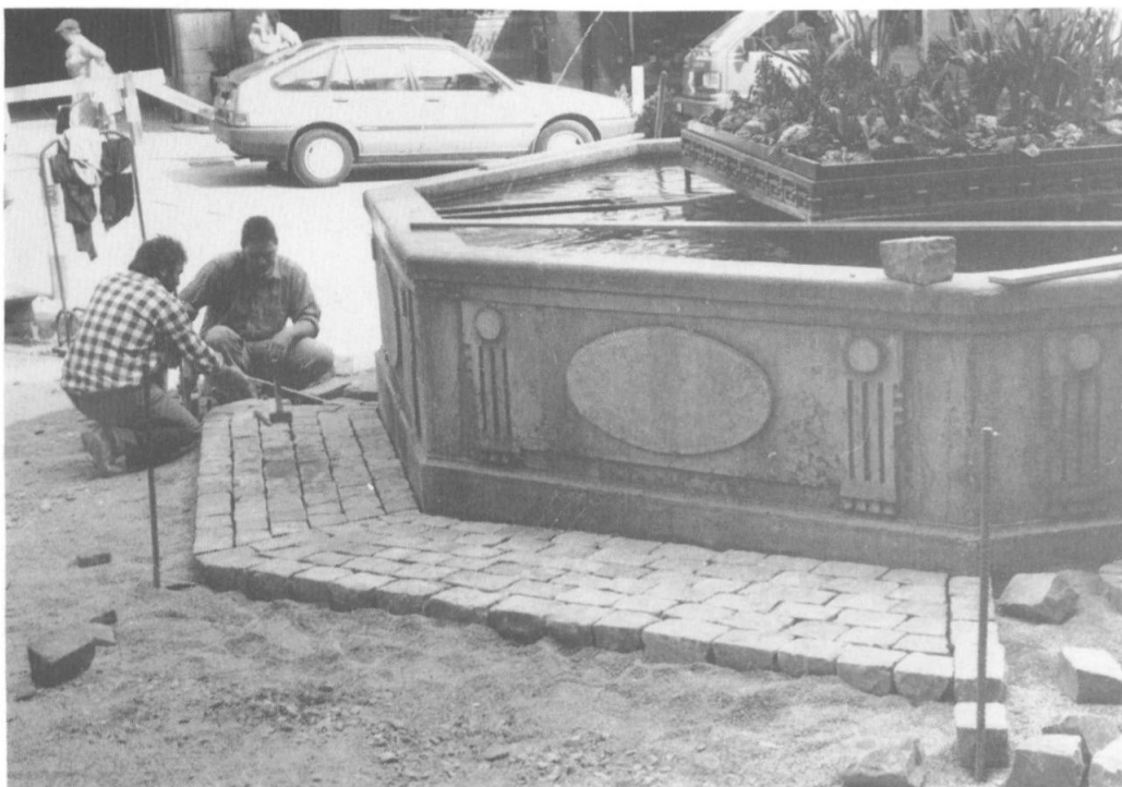
Kronenplatz: Pflasterungsarbeiten beim Brunnen.
