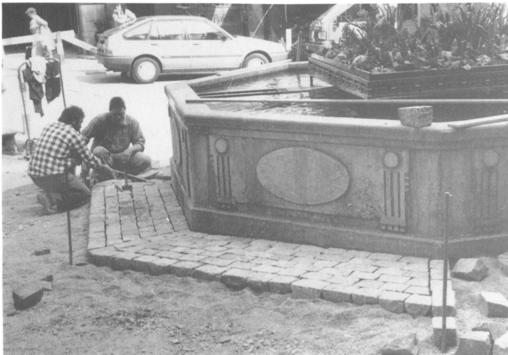
Kronenplatz: Pflasterungsarbeiten beim Brunnen.
