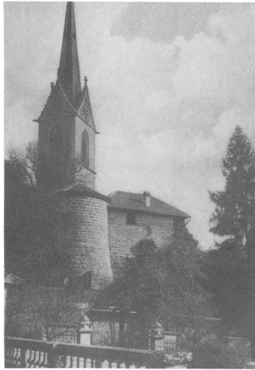
57 Kirchturm und Stadtmauer vom Kreuzgraben aus, um 1930.
