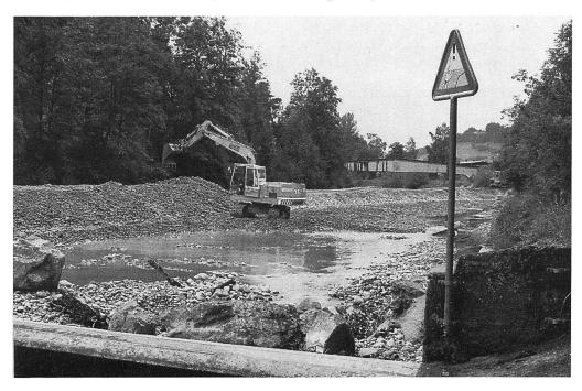
Nachdem die rund zwei Meter hohe Schwelle in der Emme auf der Höhe des Freibades unterspült und ein Teil der Uferpartie eingestürzt war, wurde das Gefälle mit einer neuartigen Blockrampe auf eine Strecke von 15 Meter verteilt. – Unser Bild: Der Flusslauf wird im September 1991 vorübergehend umgeleitet (Foto: Hans Heiniger/BT).
