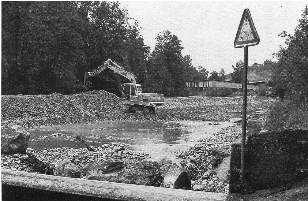
Nachdem die rund zwei Meter hohe Schwelle in der Emme auf der Höhe des Freibades unterspült und ein Teil der Uferpartie eingestürzt war, wurde das Gefälle mit einer neuartigen Blockrampe auf eine Strecke von 15 Meter verteilt. – Unser Bild: Der Flusslauf wird im September 1991 vorübergehend umgeleitet (Foto: Hans Heiniger/BT).
