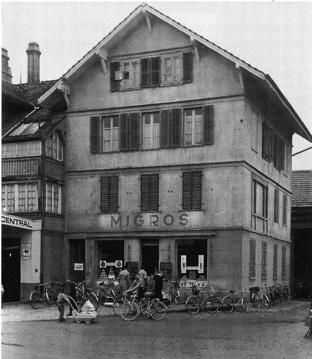
Migros-Filiale an der oberen Kirchbergstrasse, eröffnet 23. März 1932 (Foto ca. 1950).
