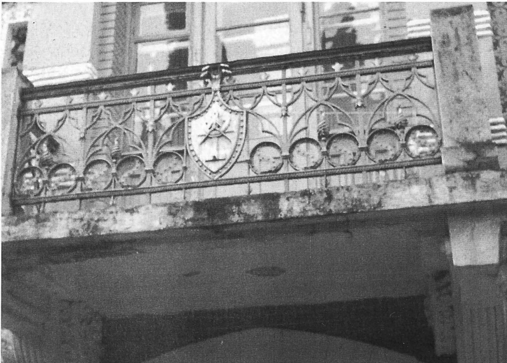
Beim Eingang auf der Nordseite Balkongeländer mit Attributen der Architekturkunst, Aufnahme von 1992.
