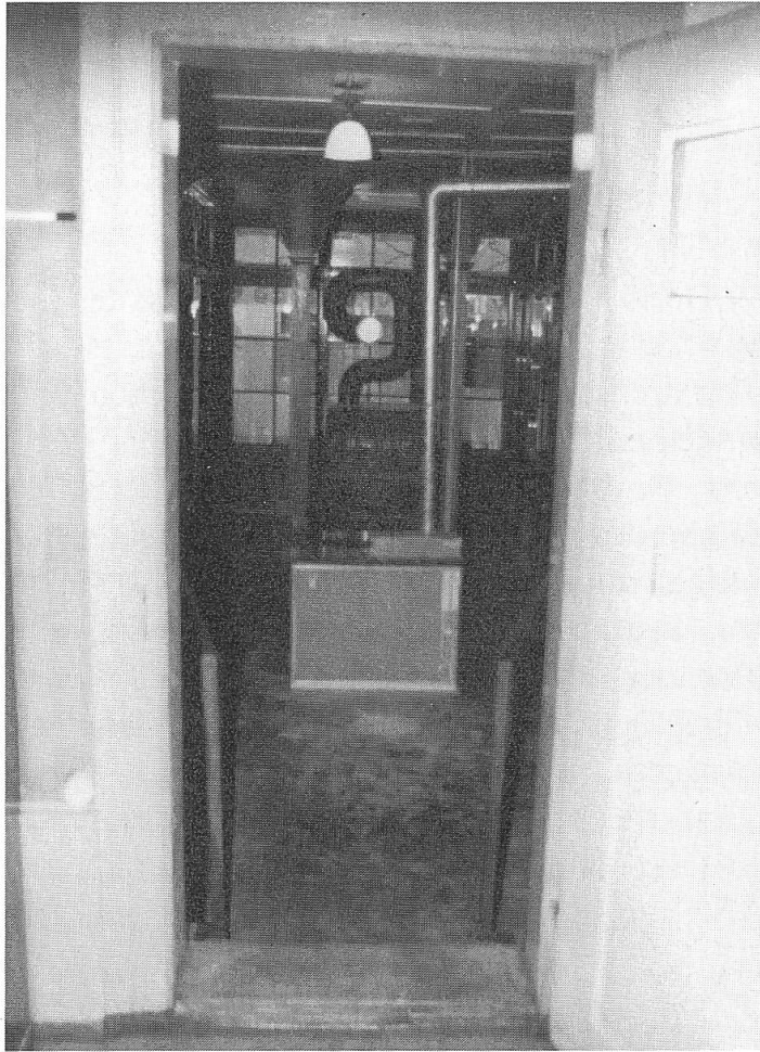
Ladeninneres vor dem Umbau 1976 (Gasheizung).
