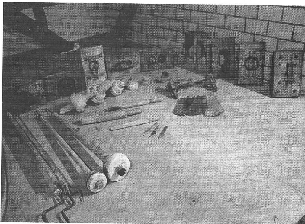
Werkzeuge, Muffenmodel, Mundstücke für Strangpresse.
