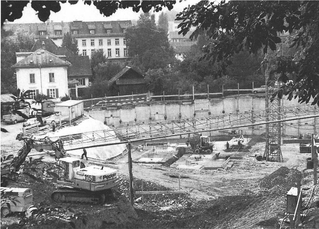
Baugrube im Herbst 1988 für die Fundamentierung des Parkhauses (Foto: bg).
