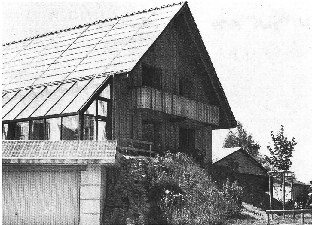
Das hundertprozentig mit Sonnenenergie betriebene Energiesparhaus kurz nach der Eröffnung im Juni 1990 (Foto: Archiv Burgdorfer Tagblatt).
