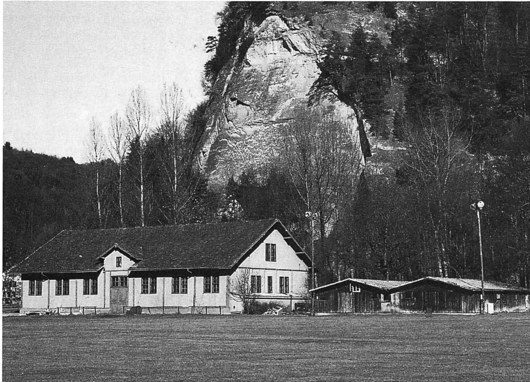
Die alte Reithalle mit der Eselsscheuer rechts davon (Foto: H. Heiniger).
