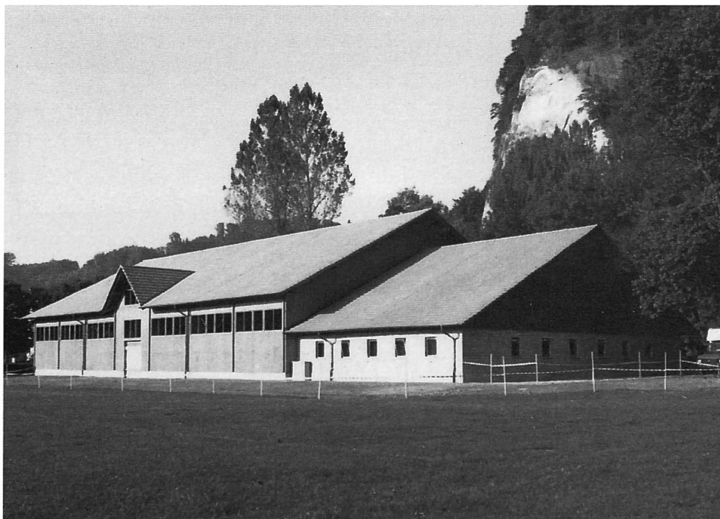
Die neue Reithalle nach der Fertigstellung, Herbst 1990 (Foto: H. Heiniger).
