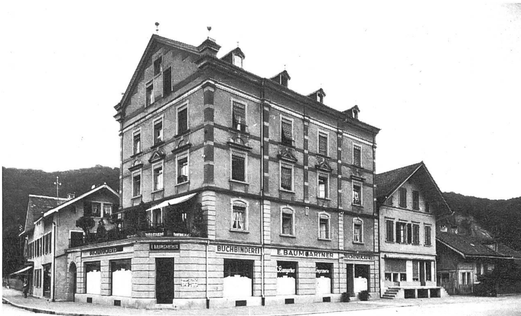
Geschäfts- und Wohnhaus 1928 an der Wynigenstrasse 19.
