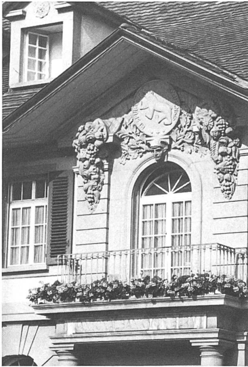
Kantonbank von Bern, Bahnhofstrasse 2.
