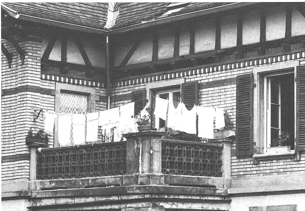
Strandweg 2: Balkon mit Gitterwerk aus Ziegelsteinen.
