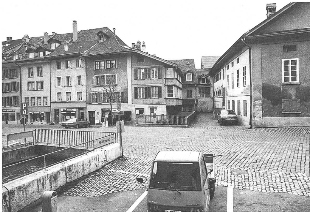
Metzgergasse 13 vor dem Abbruch (Foto: Rudolf Kräuchi).
