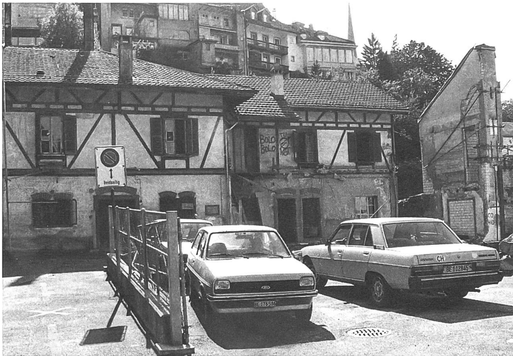
Kronenhalde 3–5, rechts die bereits abgebrochene Schweineschlächterei mit dem freigelegten Chorbogen (Foto: Beat Gugger, Sommer 1989).
