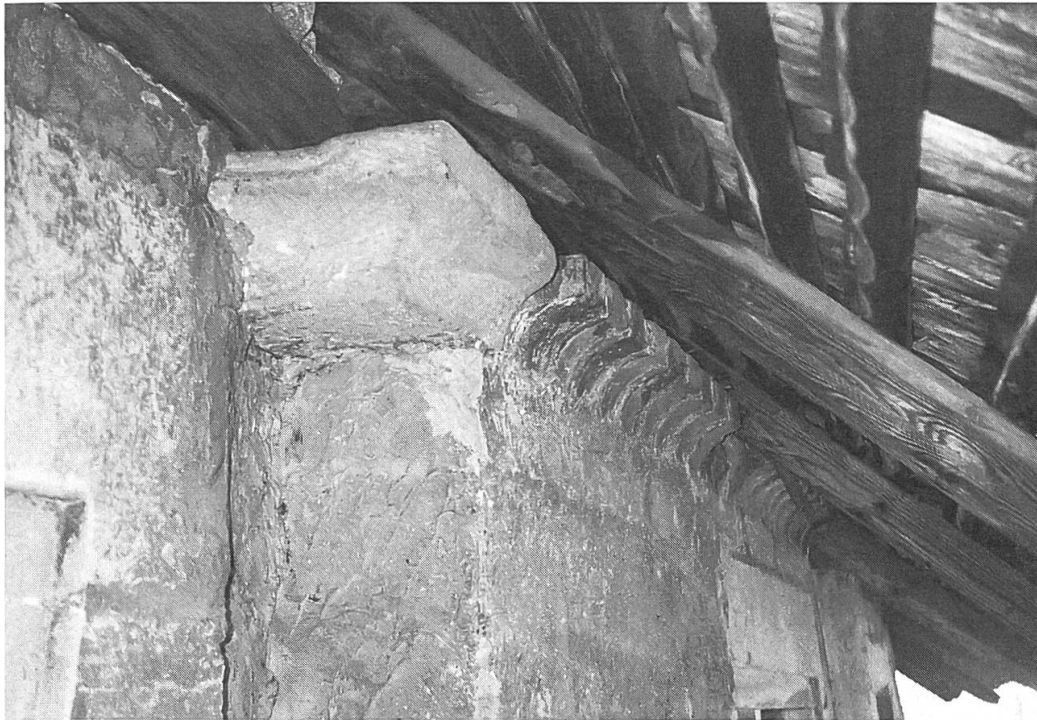
12 Nordmauer, Kranzgesims im Bereich des Übergangs zum Hausteil C (links), Eckstück aus Sandstein.
