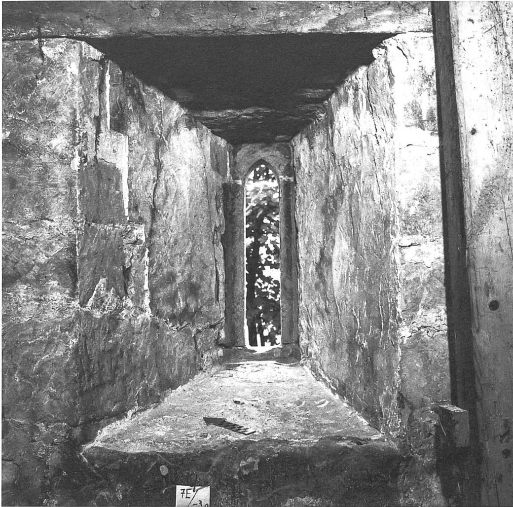
7 Keller A, Nordwand, mittleres Fenster. Ursprünglicher Mauerverband an der linken Leibung teilweise freigelegt.
