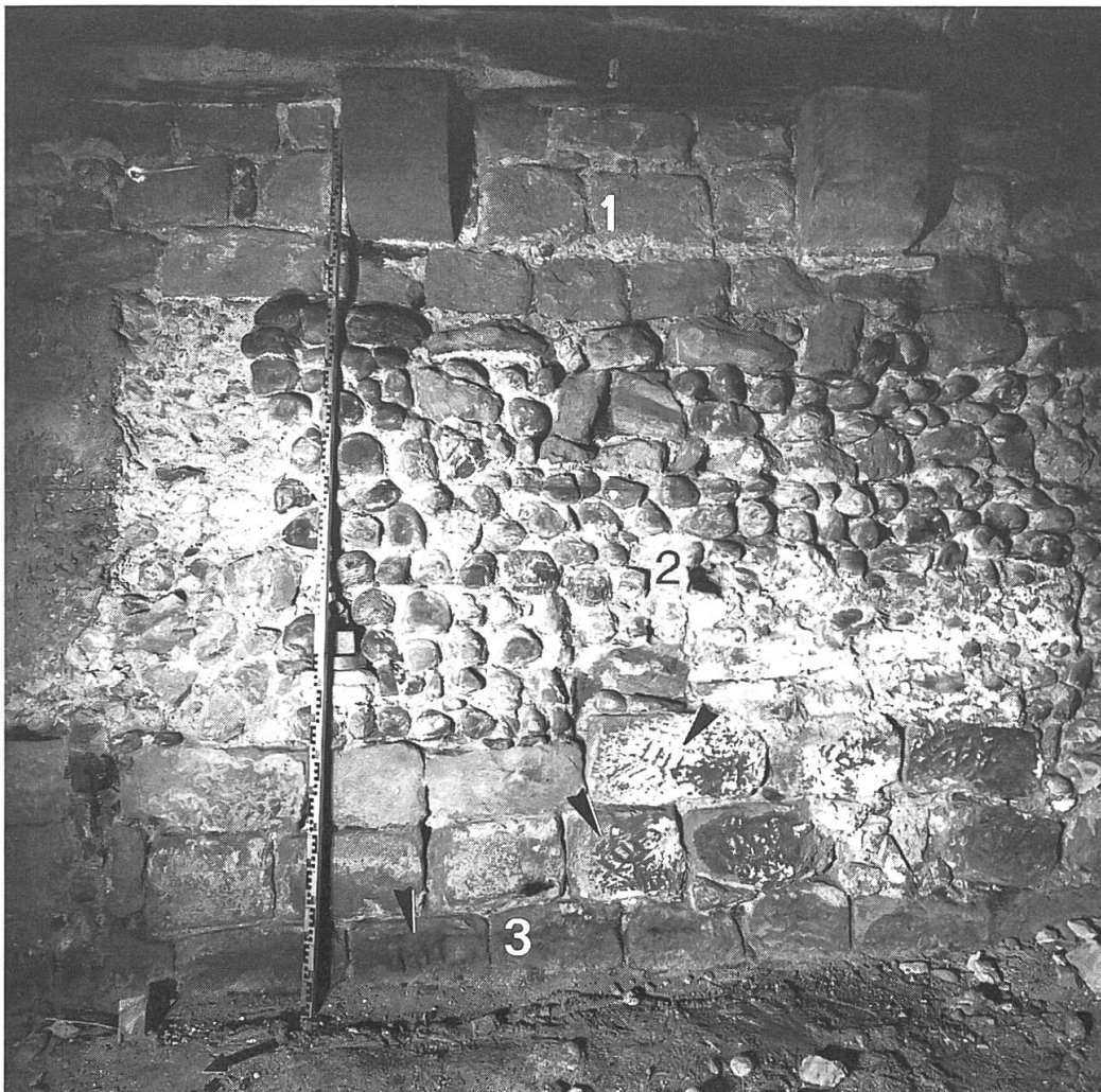
11 Keller B, Sicht an die Ostwand von Gebäude C: 1 Quaderwerk; 2 Bollensteinfundament; 3 Unterfangung mit Quadern, gut erkennbare Versetzmarken (Pfeile).
