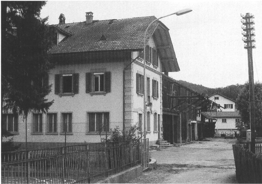
Die alten Gebäude im Neu Hof kurz vor dem Abbruch 1986 (Foto: Beat Gugger).
