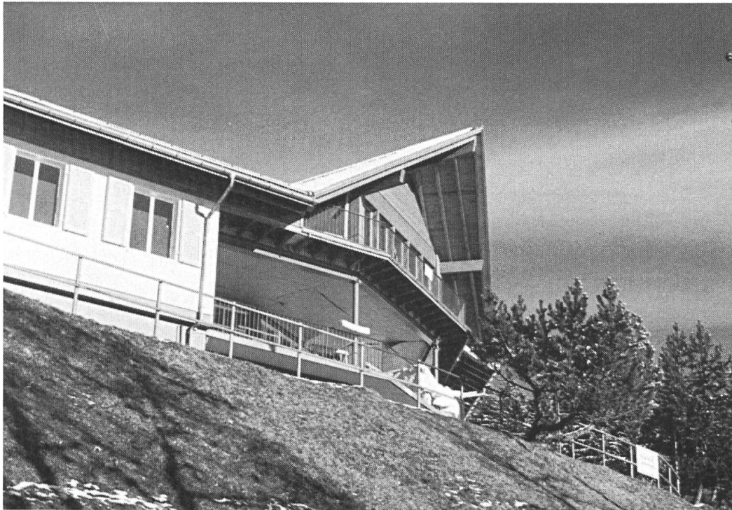
Das Ferienheim Waldegg-Beatenberg mit dem neuen Dach (Foto: Heinz Schibler).
