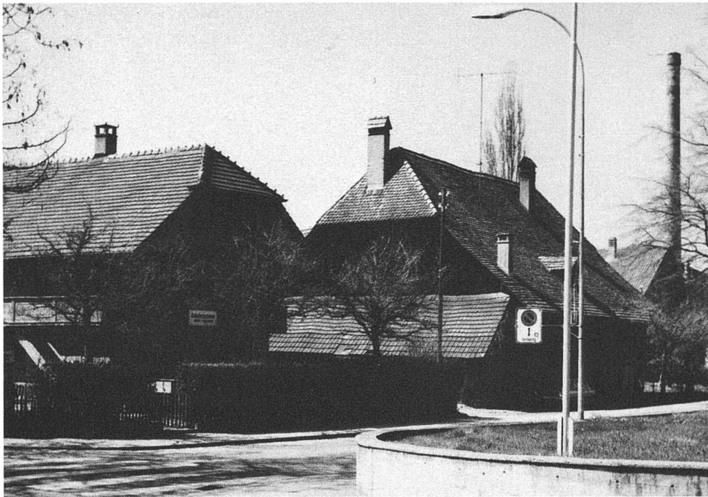
Die beiden abgebrochenen Häuser an der Lyssachstrasse (Schuhmacherei Wiedmer, Bauernhaus Iseli). Foto: F. Gösmann, Frühjahr 1983.
