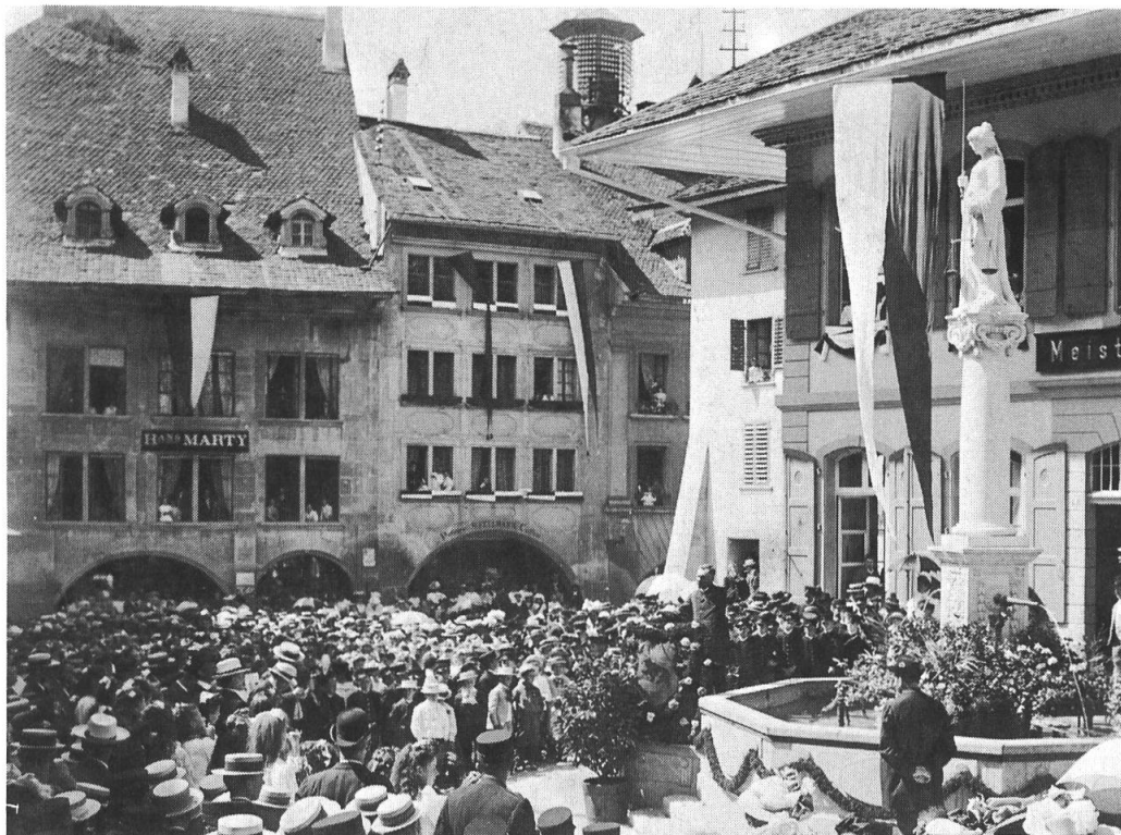
Kronenplatz mit Haus Hohengasse 39, auf dessen Dach der mächtige Korb mit Drähten und Isolatoren zu sehen ist.
