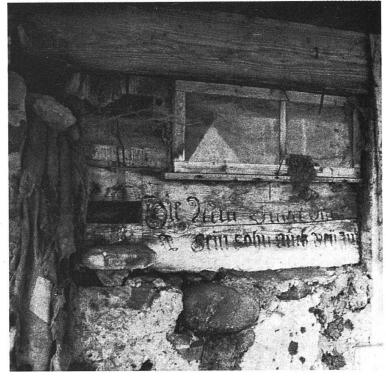
Schwelle mit Inschrift vor Renovation. Links der Bildmitte sind die Überreste eines Speicherfusses und eines Schwellenschlosses erkennbar.
