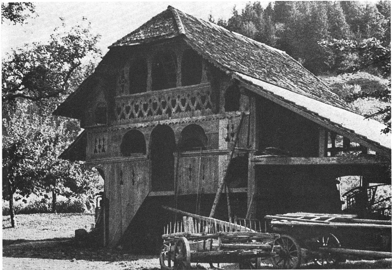
Zustand des Speichers im Fischbach vor Renovation. Erkennbar sind der Zugang zum nichtauthentischen Speicher im Untergeschoss sowie der angebaute Lagerschopf.
