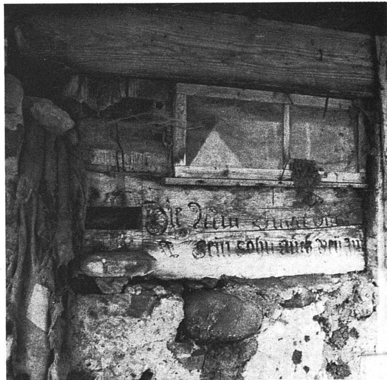
Schwelle mit Inschrift vor Renovation. Links der Bildmitte sind die Überreste eines Speicherfusses und eines Schwellenschlosses erkennbar.
