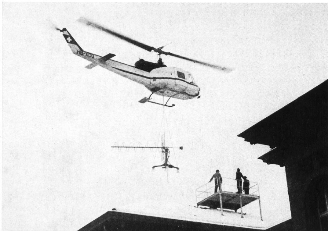
Abb. 2 Die Antenne wird auf das Podest geflogen
