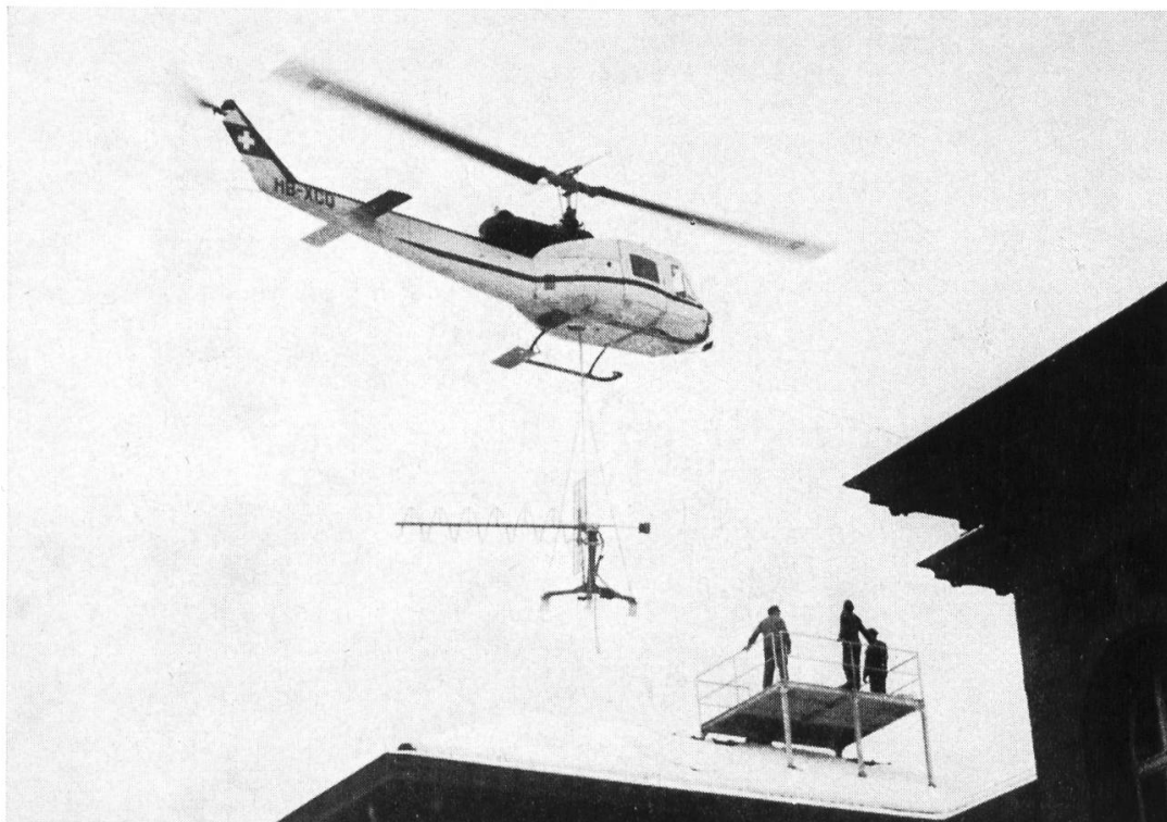
Abb. 2 Die Antenne wird auf das Podest geflogen
