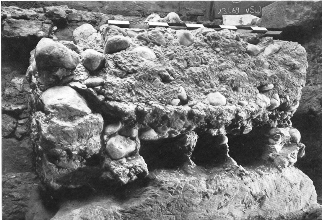
Abb. 9 Annexwestmauer (7), Südflucht. Balkenrost (Löcher) auf gewachsenem Boden. Links Anstückung (Fuge bei linkem Meterende) für das Seitenschiff (11) Text S. 20f.
