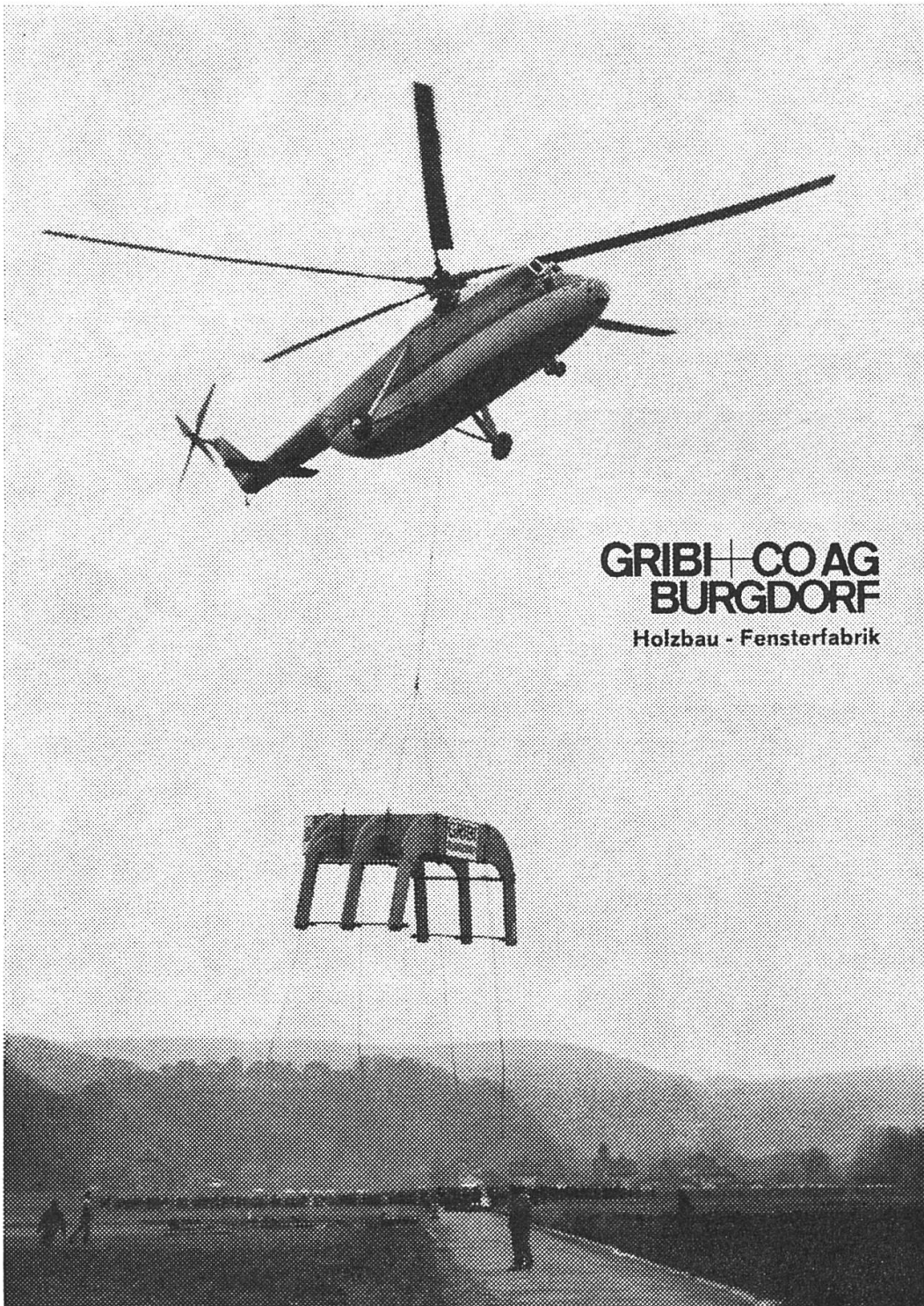
Transport einer Holzkuppel von 7 t von Burgdorf auf den Turmkopf des Eidg. Amtes für Maß und Gewicht in Wabern-Bern
