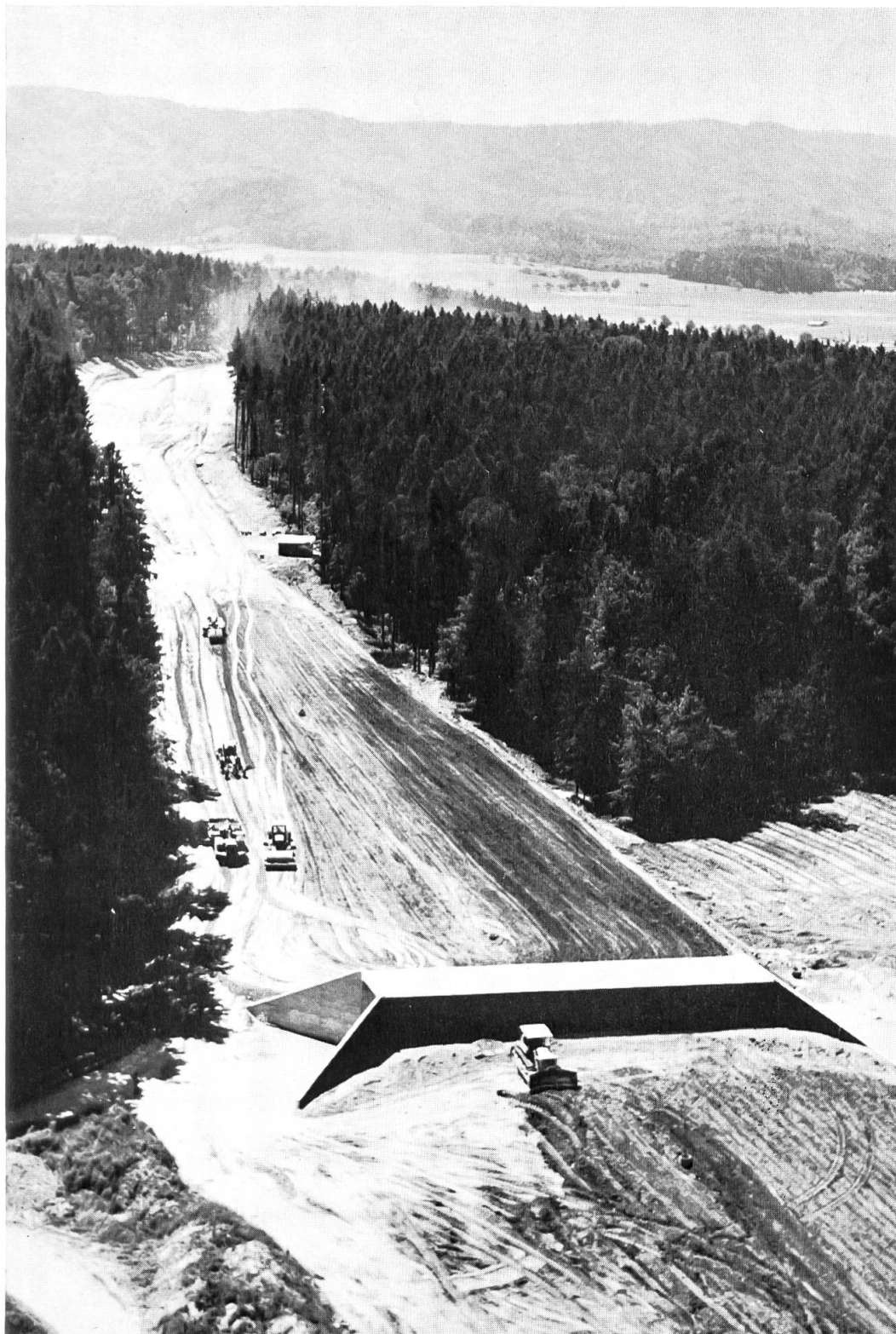
Die Nationalstraße Nr. 1 im Bau Kurve im Oberhardwald zwischen Hindelbank und Mattstetten; Feldwegunterführung
