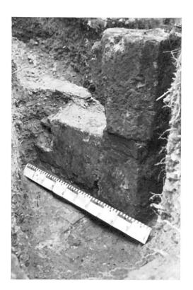
Abb. 12 Der östliche Türpfosten (vgl. Abb. 11); man beachte zwischen 1 und 5 des Maßstabes den Verputz, zwischen 5 und 6 den gerillten Backstein unter einer Mörtellage
