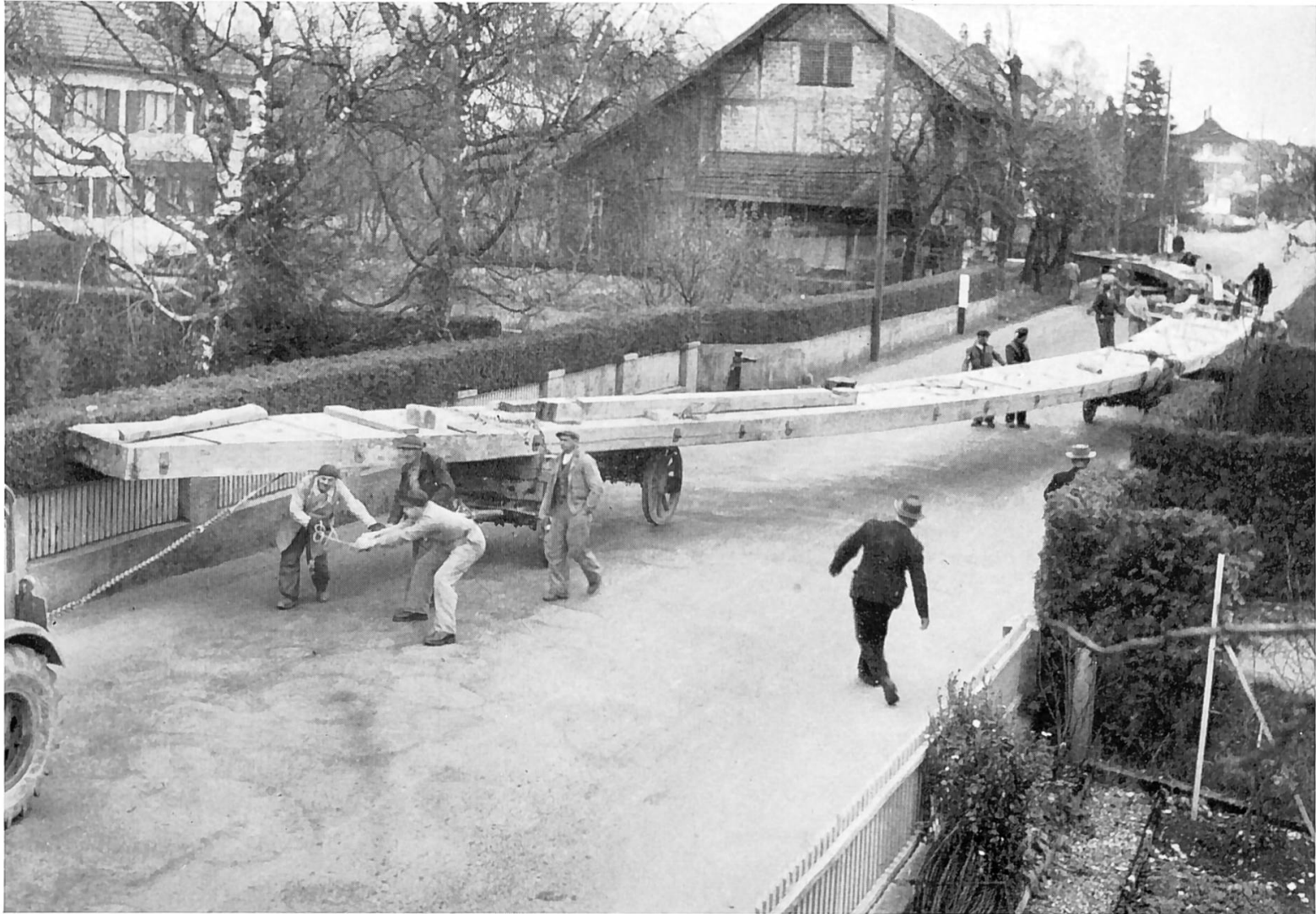
Transport der Hauptträger: 18. November 1955
