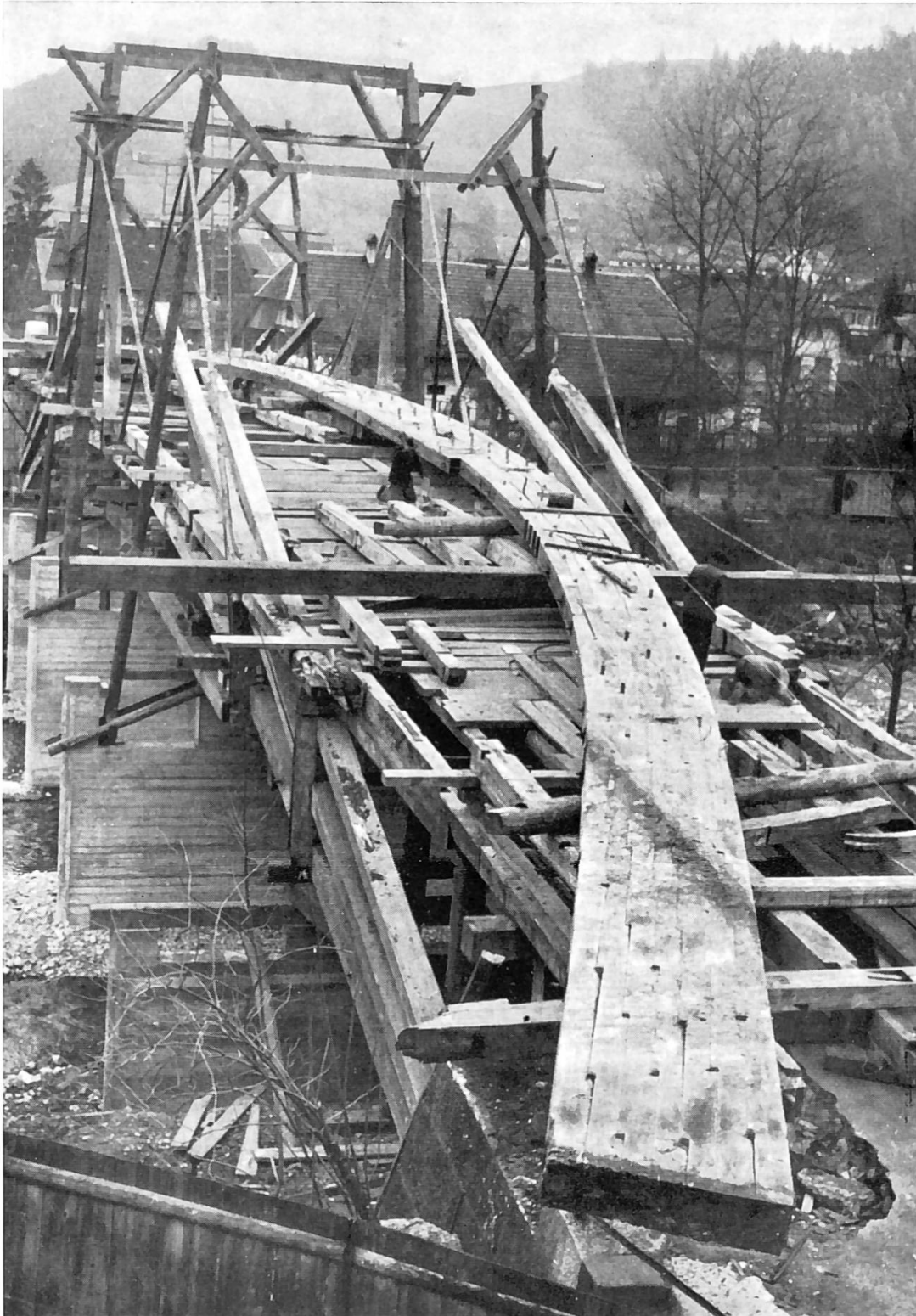
Abbau der Holzbrücke auf Hilfsjochen: 10. November 1955
