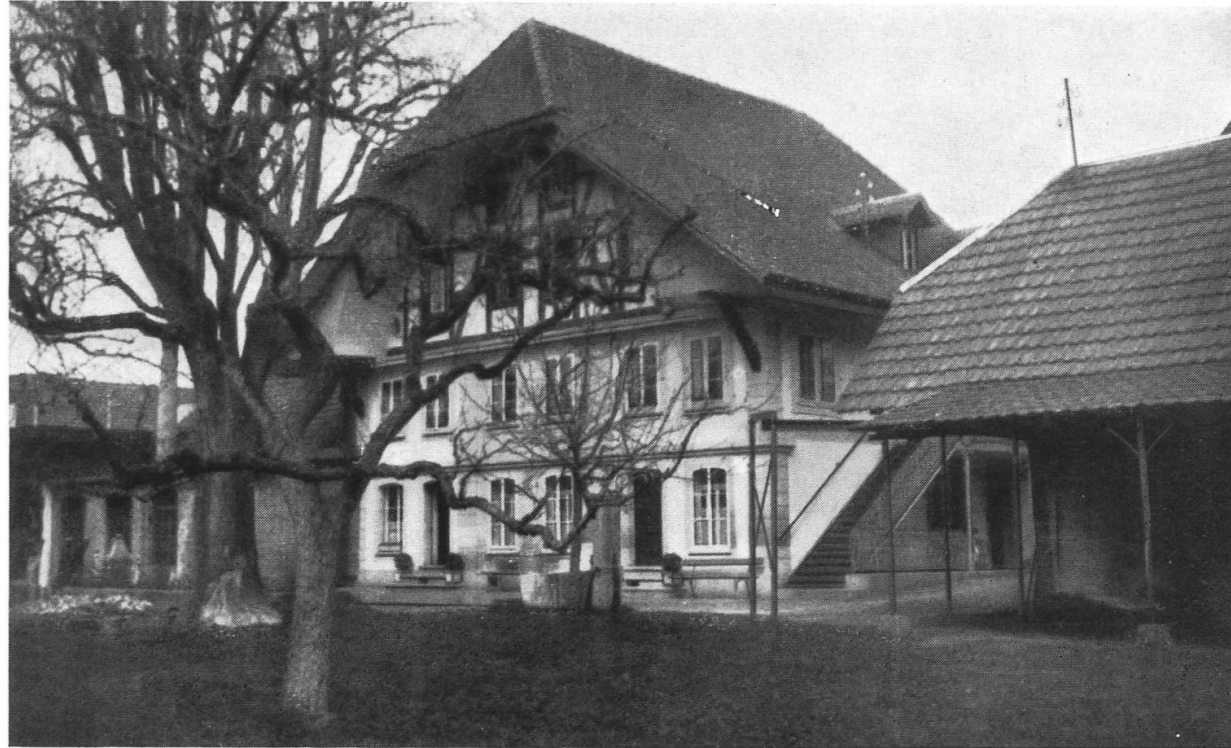
Wohnhaus der Hammerschmiede Flüchiger in Oberburg
