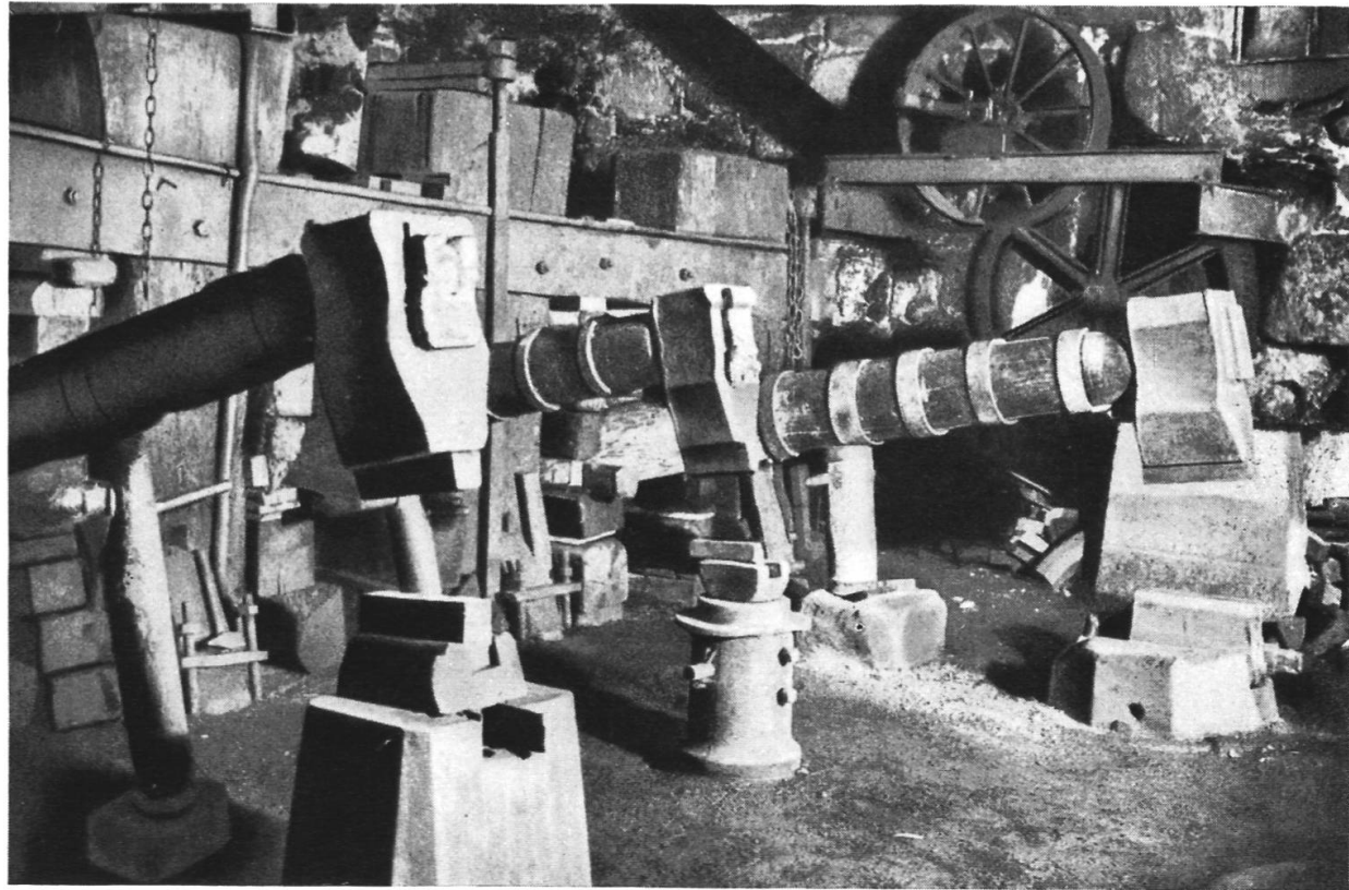
Altes Schwanzhammerwerk aus Oberburg In Betrieb 1870—1948
