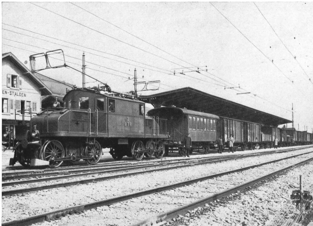
Moderne Drehstromlokomotive aus dem Jahre 1911
