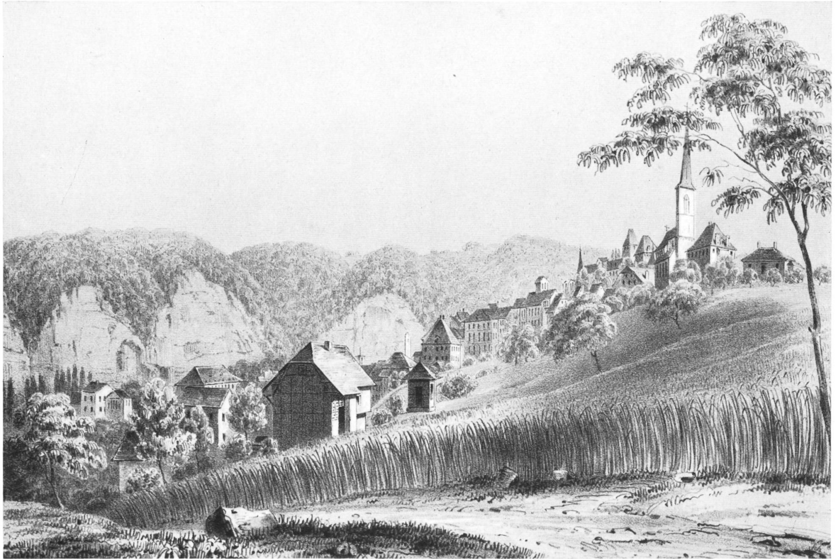
Fig. 116 Burgdorf vom Gsteig aus
