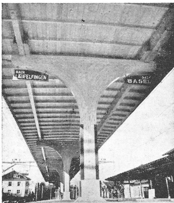
Perrondach S.B.B. Bahnhof Liestal Hetzerkonstruktion ausgeführt durch Gribi & Co. AG.
