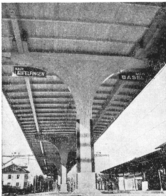
Perrondach S. B. B. Bahnhof Liestal. Helzerkonstruktion ausgeführt durch Gribi & Co. AG.
