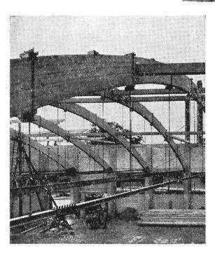
Neues Lagerhaus der Firma Courvoisier & Co. Biel. Hetzerbinder mit 30 m Spannweite.
