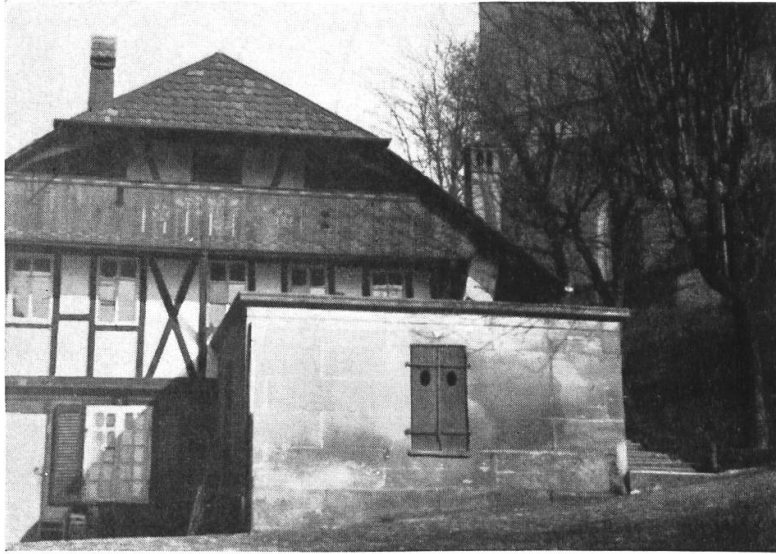
Haus «Neuengasse Nr. 2», bisheriger Zustand
