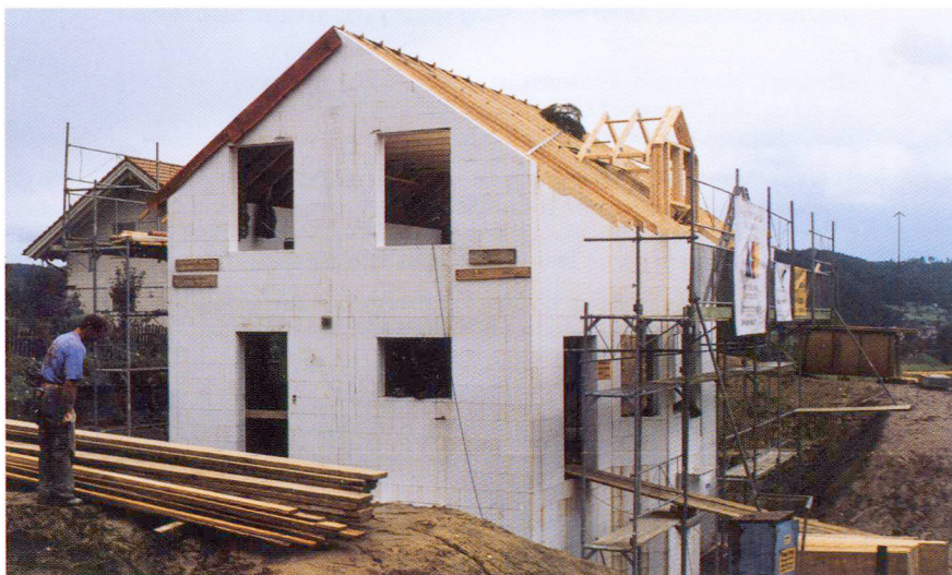
Gros œuvre de la maison modèle de Brittnau 15 jours après le début des travaux.
