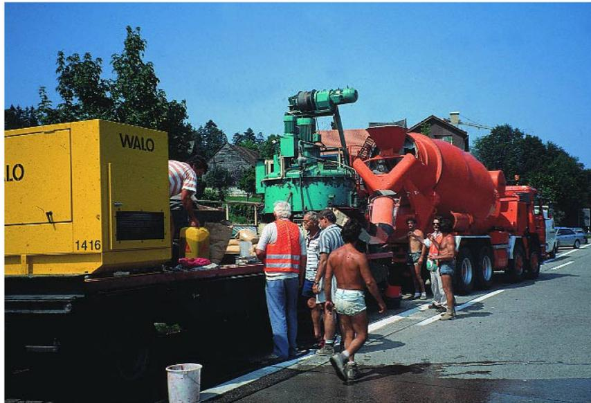
On utilise généralement des bétons B 40/30 résistant au gel et aux sels de déverglaçage. On attache plus d'importance à la résistance à la traction par flexion de ces bétons – dont la valeur moyenne doit être de 5,5 N/mm<sup>2</sup> après 28 jours – qu'à la résistance à la compression dont ils témoignent. Les mesures sont effectuées sur des prismes normalisés.
