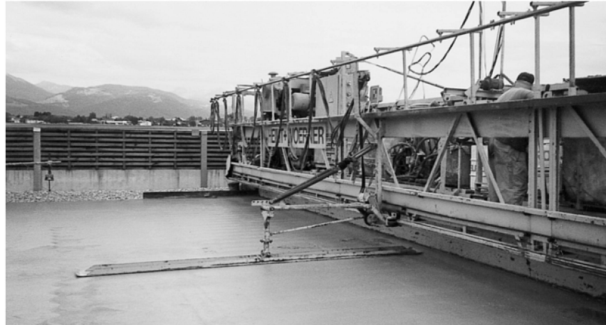
Talocheuse longitudinale en action.
