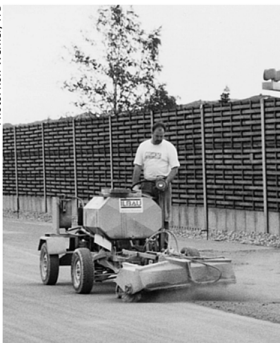
Réalisation de la surface en béton lavé atténuant le bruit par brossage mécanique.
