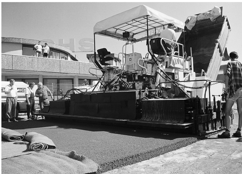
Mise en place de béton drainant.
