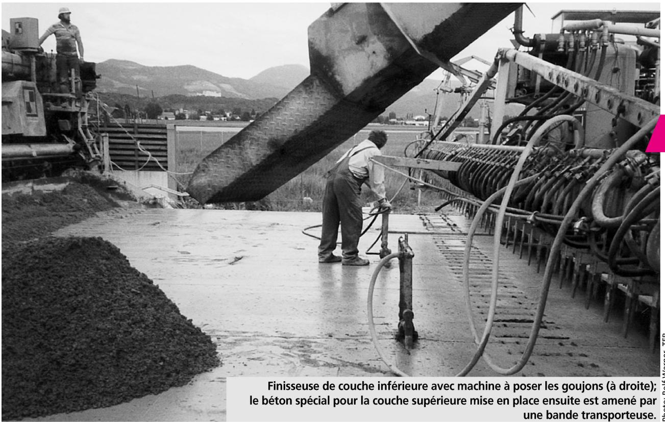
Finisseuse de couche inférieure avec machine à poser les goujons (à droite); le béton spécial pour la couche supérieure mise en place ensuite est amené par une bande transporteuse.
